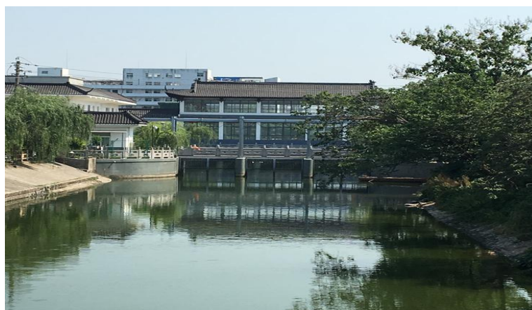
图 1-3 安墩河引桥路段现状情况图
